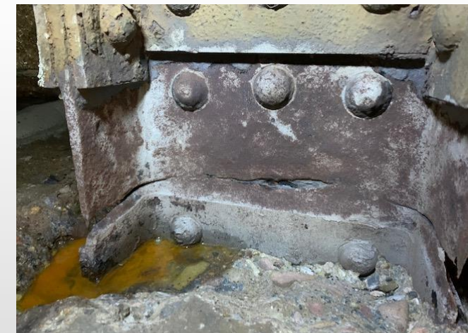
Zuglagerschaden
